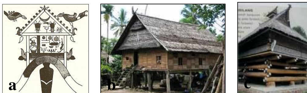
Gambar 1. a. Rumah Ngaju Dayak (Kanan) (Sumber: Schärer 1963) dalam Sato 1991), b. Konstruksi Rumah Panggung dengan Tiang Berdiri (Sumber: http://pic.leech.it/i/7fa31/90ab3d49southsulaw.jpg ), c. Konstruksi Panggung dengan Kayu Bersilangan (Sumber: Tjahyono & Davison dalam Tjahyono 2002)
