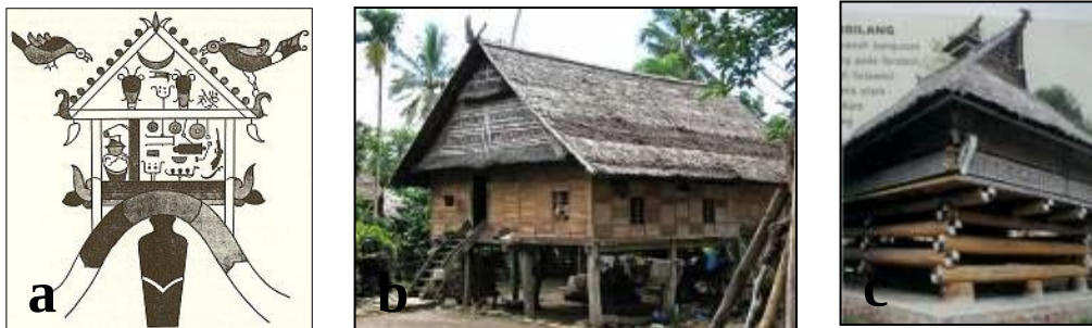
Gambar 1. a. Rumah Ngaju Dayak (Kanan) (Sumber: Schärer 1963) dalam Sato 1991), b. Konstruksi Rumah Panggung dengan Tiang Berdiri (Sumber: http://pic.leech.it/i/7fa31/90ab3d49southsulaw.jpg ), c. Konstruksi Panggung dengan Kayu Bersilang (Sumber: Tjahyono & Davison dalam Tjahyono 2002)
