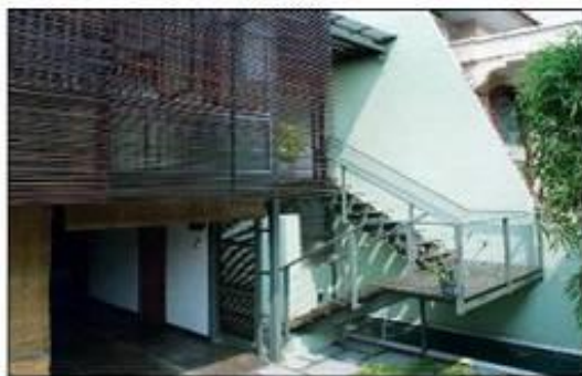
Gambar 9. Rumah Panggung Modern (Sumber: http://www.kompas.com/data/photo/2008/05/08/153139p.jpg )
