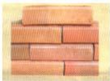
Gambar 4 : Tampilan bata wina dipasang dengan menggunakan nat, tidak terlihat dari luar.
