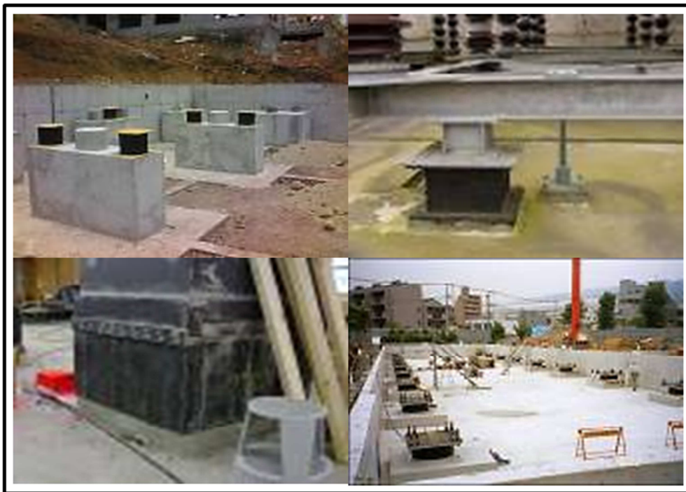
Gambar 7, Perletakan bantalan karet pada tiap kolom (Sumber ; Bahan Ceramah Ilmiah, Microtremor Observation, Khyusu University -Universitas Tadulako)
