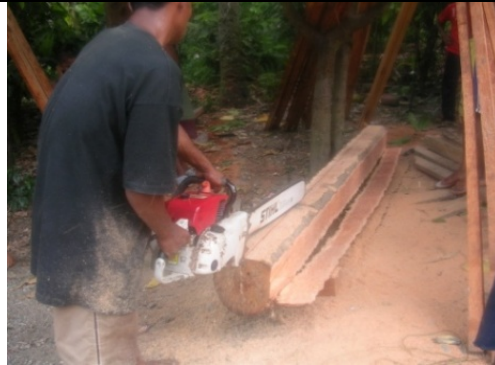
Pemotongan batang 'kayu kelapa' untuk dijadikan balok-balok konstruksi, menggunakan alat semi mekanik (chain-saw)
