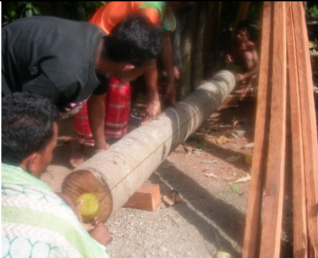
Pengukuran batang 'kayu kelapa' sebelum dilakukan pemotongan sesuai ukuran yang dibutuhkan
