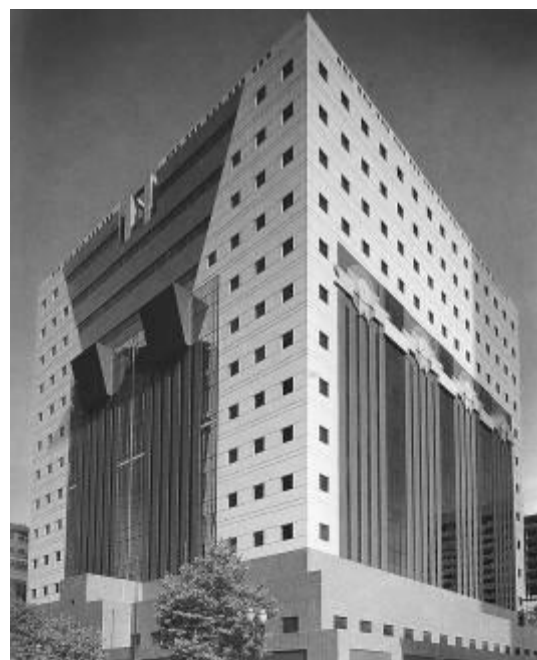
Gambar 7. Gedung Portland. Gaya arsitektur Post-Modern (Sumber: Moffet, 2003)
